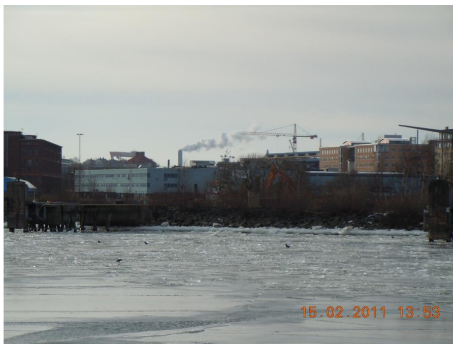
Figur 4 Erosionsskydd vid kajplats 116 inom utredningsområde, H051.
